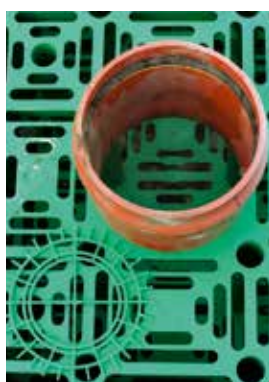
200 mm PVC-U caurules ievietošana atverē.
