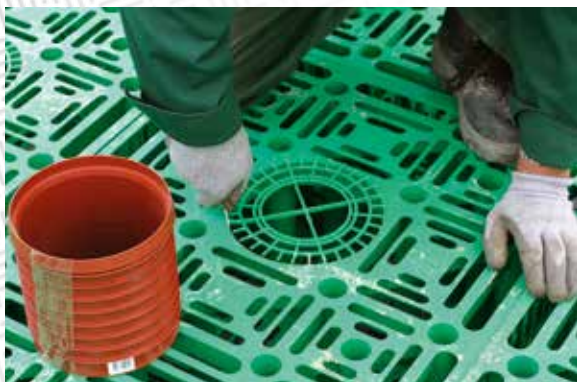
Atveres režģa izgriešana DN/OD 200 mm caurules pievienošanai kasetes augšpusē.
